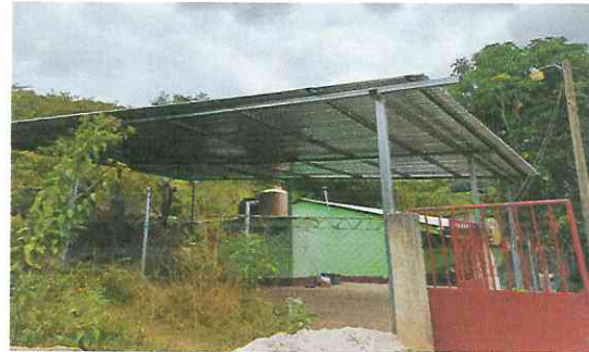
Foto 2: MODULO 1 TECHADO DE PATIO
