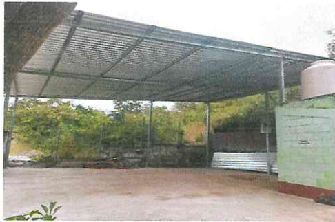
Foto1: MODULO 1 TECHADO DEL PATIO
