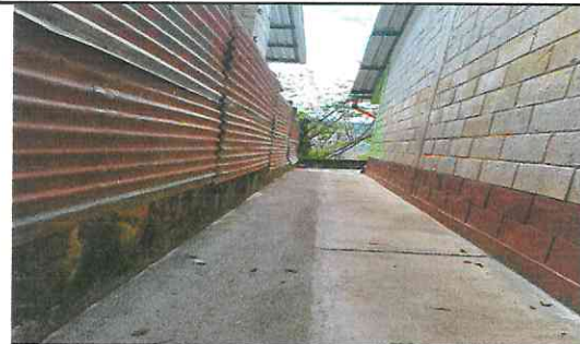
Foto 4: MODULO 2 TORTA DE CEMENTO
