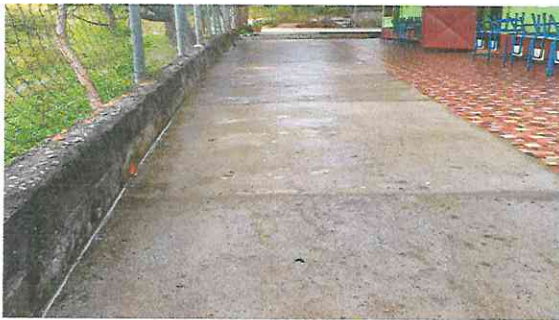
Foto 3: MODULO 2 TORTA DE CEMENTO
